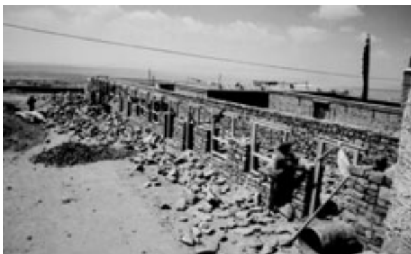
Bauarbeiten an den neu entstehenden Unterkünften
