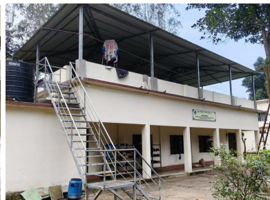
Dachsanierung- mit Zugangstreppe
