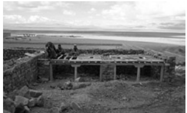
Gedeckte Trockentoilette im Bau: der Zwischenboden mit den 4 Löchern wird gelegt.
